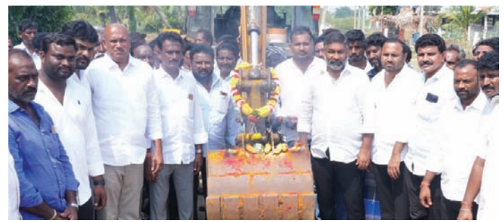
సీ.సీ.రోడ్డుకు శంకుస్థాపన చేస్తున్న కోటంరెడ్డి గిరిధర్ రెడ్డి
