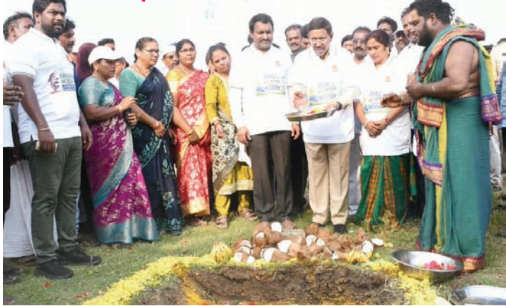
స్టేడియం నిర్మాణానికి శంకుస్థాపన చేస్తున్న మంత్రి నారాయణ
