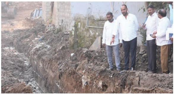
కాలువ పనులను పరిశీలిస్తున్న ఇన్-చార్జ్ మేయర్ రూప్ కుమార్ యాదవ్
