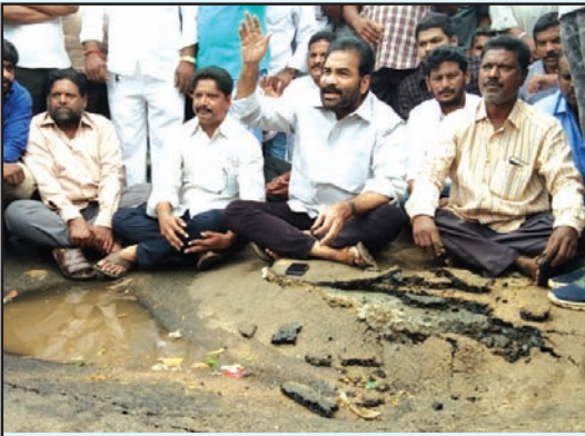
కుంగిన రోడ్డు వద్ద ధర్మా చేస్తున్న ఎమ్మెల్యే కోటంరెడ్డి
