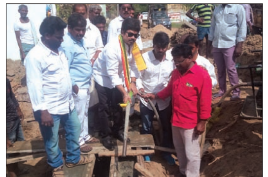
డ్రెయిన్ పనులను ప్రారంభిస్తున్న ఆనం రంగమయూర్
